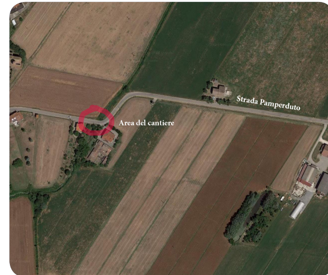
Ponte sul rio Canneto lungo la strada di Pamperduto
