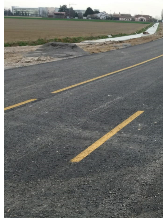
Nell'immagine i lavori di realizzazione del 4
