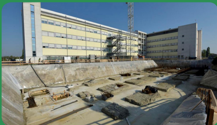
Settembre 2016 - avanzamento dei lavori esterni
