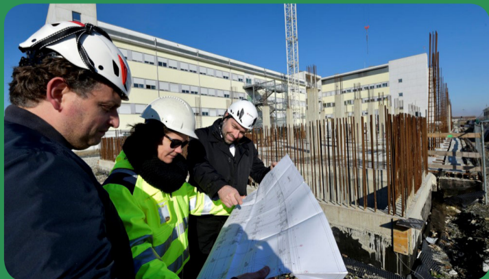
Febbraio 2018 - Riapertura del cantiere
