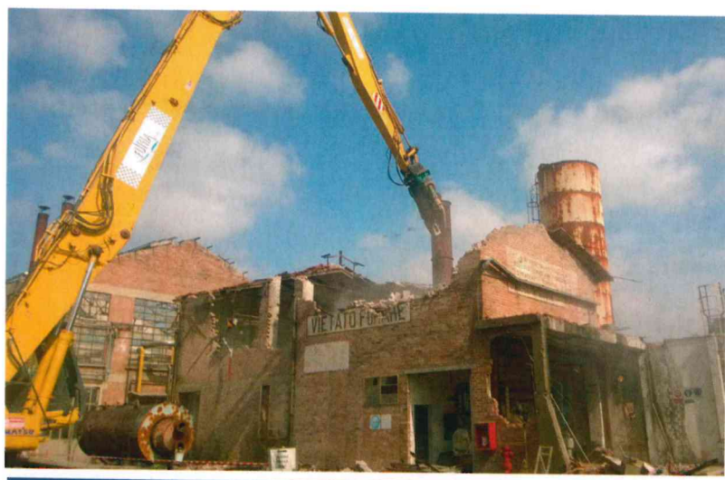
Un momento della demolizione all'ex Carbochimica
