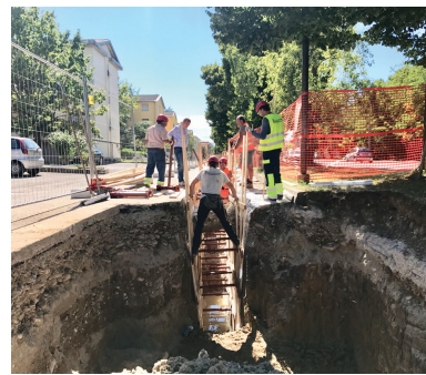
Promessa mantenuta: iniziati i lavori per interrare 2 km di rete ad alta tensione nel quartiere Europa!
