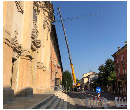
Palazzo dei Gesuiti, via ai lavori di riqualificazione con l'enorme gru da 22 metri di altezza
